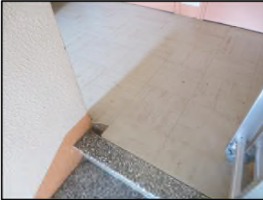
Photo N° 644 ECH-N°1 REVETEMENT DE SOL --PALIER VOLEE ESCALIER +1 Planchers Dalles de sol beige 30x30 avec colle noire
